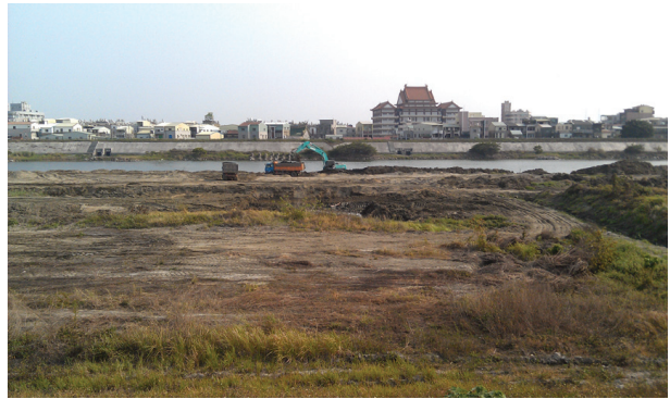
第六河川局大甲濕地正在進行土方調整的工程，對於灘地地貌將有改變
