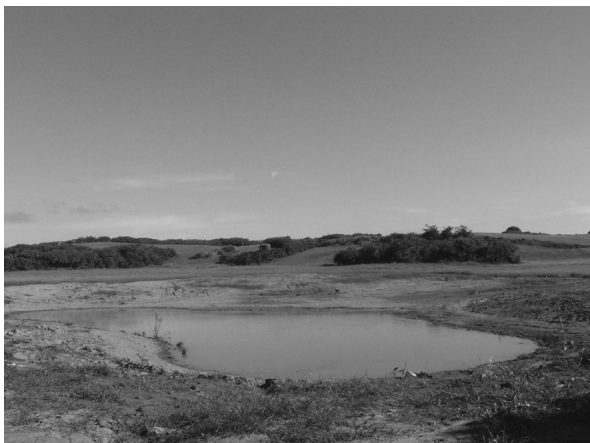
生態池完工適逢7月雨季為生態池注入水源
