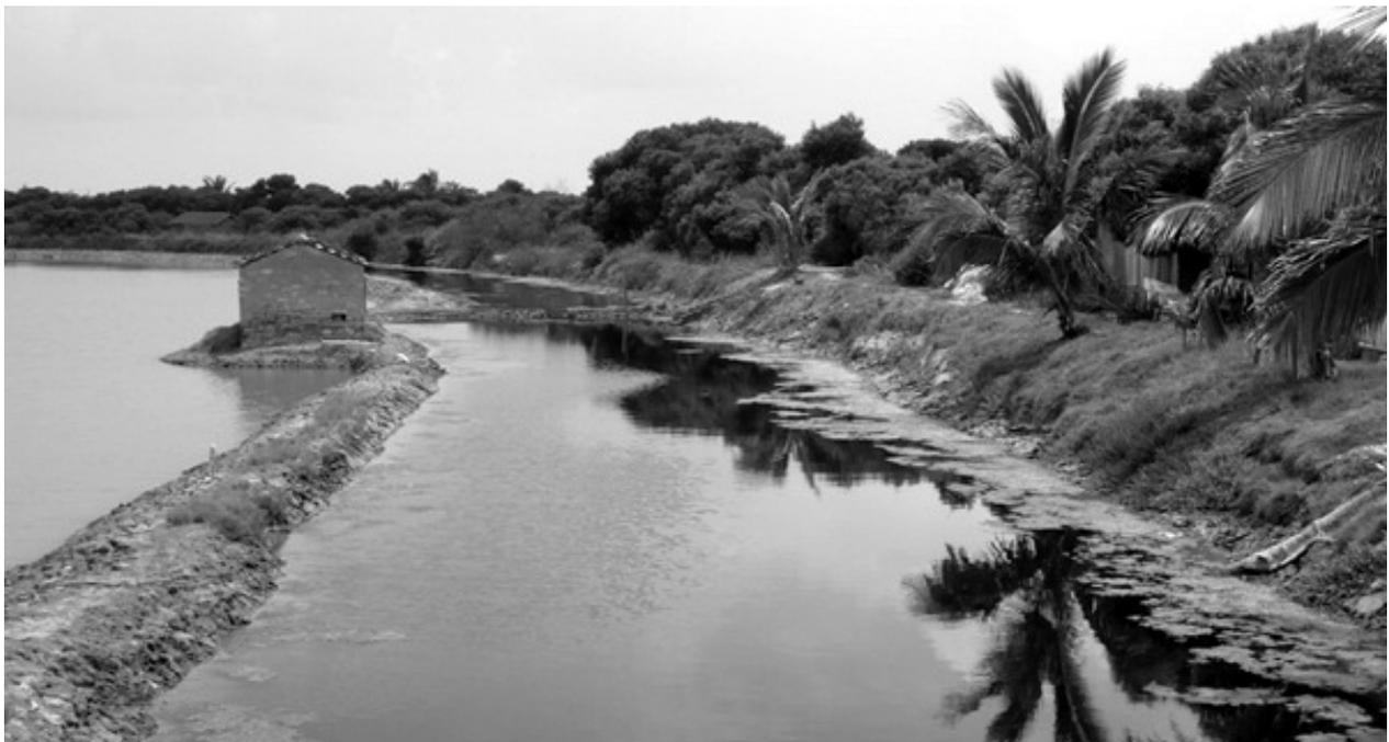
這就是現有土堤C與D之間的水道，河川局要興建堤岸，應建在左側房子的這一道土堤，即上圖D的堤岸。
