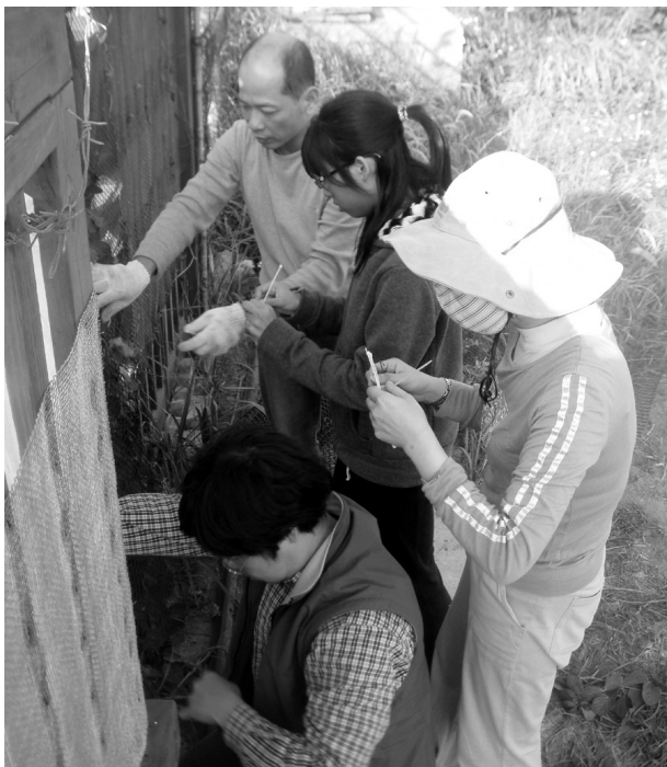
很專注地修補每一處破損的圍籬
