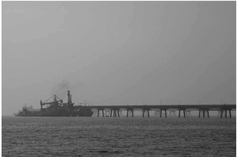
興達港火力發電廠卸煤碼頭與輸送管
