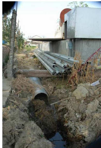
牛糞以暗埋水管排至水溝
