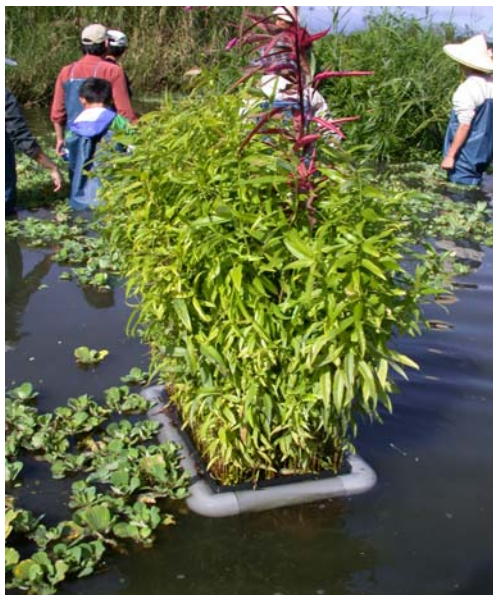
以竹筏、漂浮木、塑膠管等做成圓形、矩形、長方形或隨池形變化
