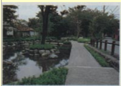
打掉柏油路面恢復河川水道後
