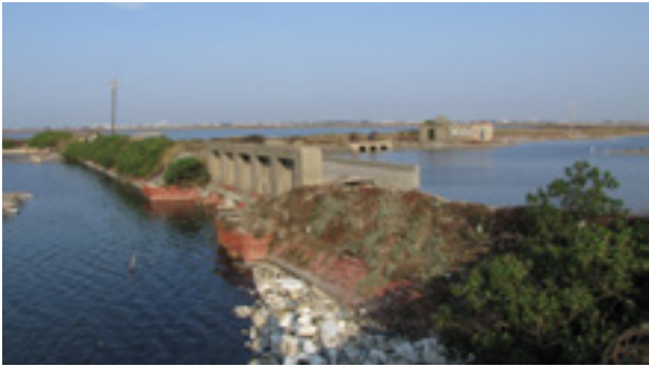
引海水進入 30 公頃蓄水池開門
