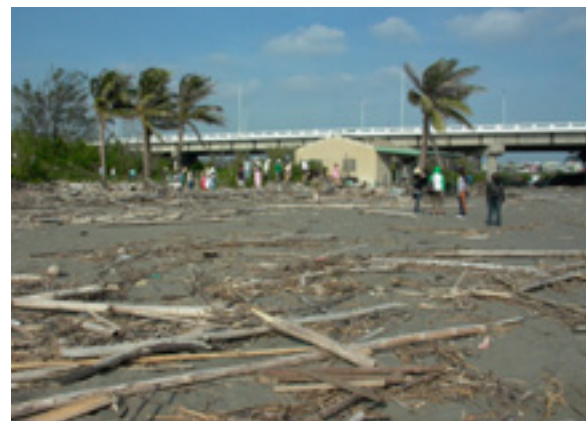
二仁溪出海口，魚塢土堤沖破，直接沖刷到房子邊 _20060915。
